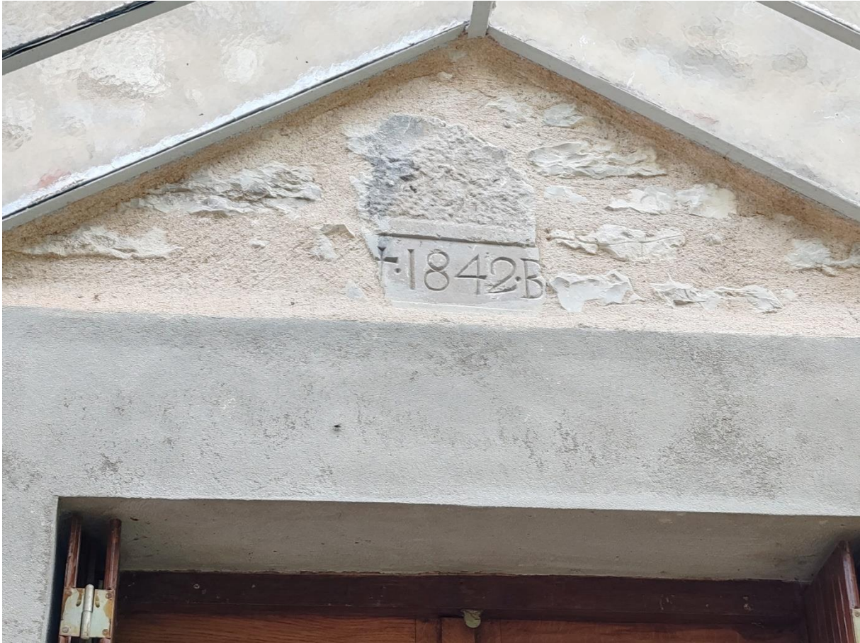
Linteau de la porte d'entrée de l'habitation existante. Photographie prise le 06.08.2025.
